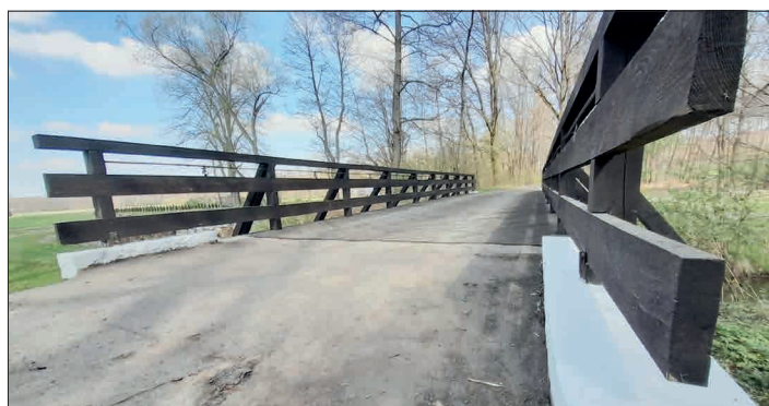
Most na Głębczu został wyremontowany i znowu bezpiecznie służy m.in. amatorom turystyki rowerowej
