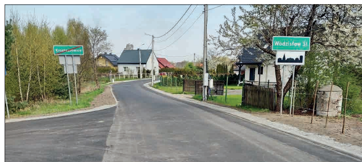
Przebudowa ul. Czarneckiego i końcowego odcinka ul. Wodzisławskiej była możliwa również dzięki zaangażowaniu finansowemu Gminy Godów
