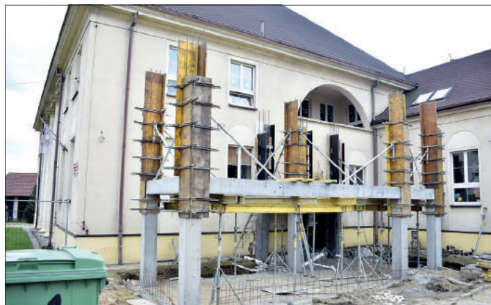
Dodatkowa klatka schodowa z windą ma być gotowa do połowy października tego roku. Stan zaawansowania prac na początku kwietnia.
