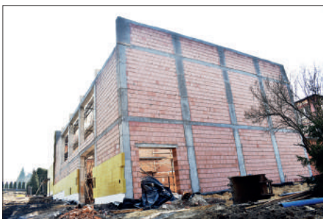
Stan budowy sali z marca 2022 r.
