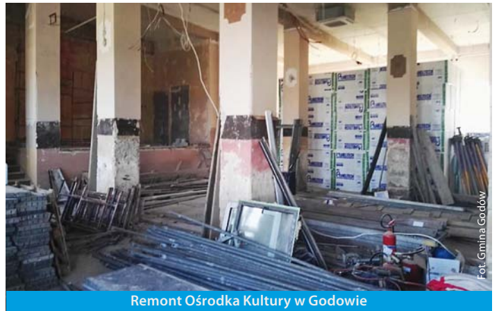
Remont Ośrodka Kultury w Godowie
