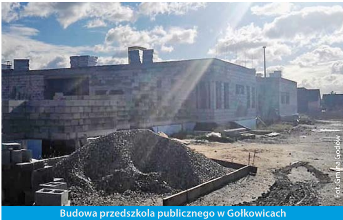
Budowa przedszkola publicznego w Gołkowicach
