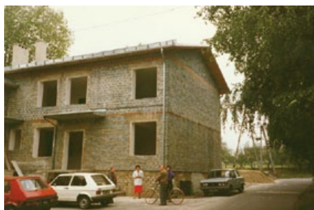
Budowa Wiejskiego Ośrodka Kultury w Skrzyszowie
