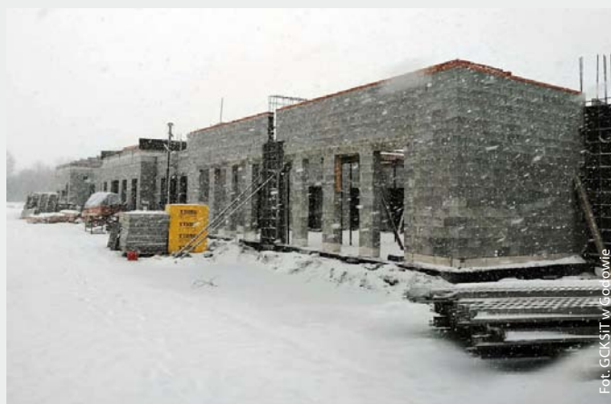
Budowa Przedszkola Publicznego w Gołkowicach, 2018 r.
