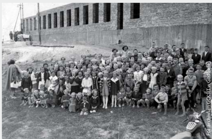
Budowa Szkoły Podstawowej w Godowie, lata 1959-1961
